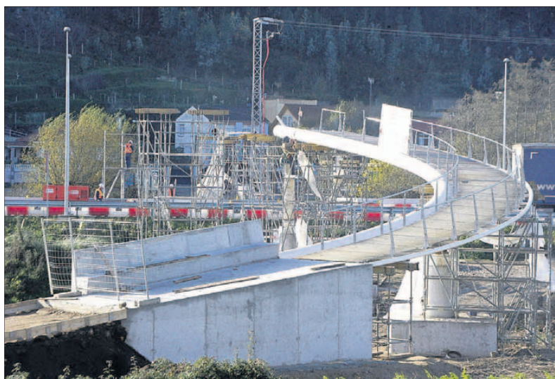
Operarios trabajan para instalar la pasarela en O Seixedo durante diciembre. | VÍCTOR ECHAVE
